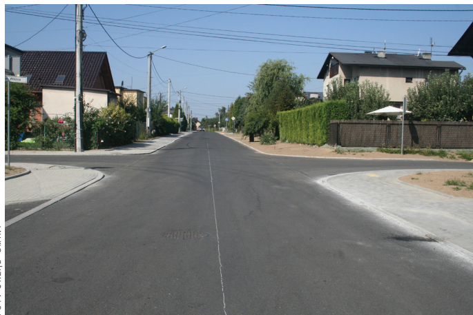
Ulica Żeromskiego po zakończeniu prac remontowych.
