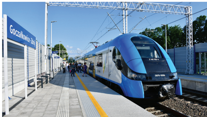
UG Stacja została przebudowana w ramach dużej inwestycji kolejowej (Fot. UG)
