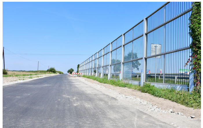
Na fragmencie nowej drogi wzdłuż DK 1 są już pierwsze warstwy asfaltu (Fot. UG)
